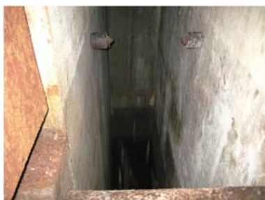
La fosse à pieux
