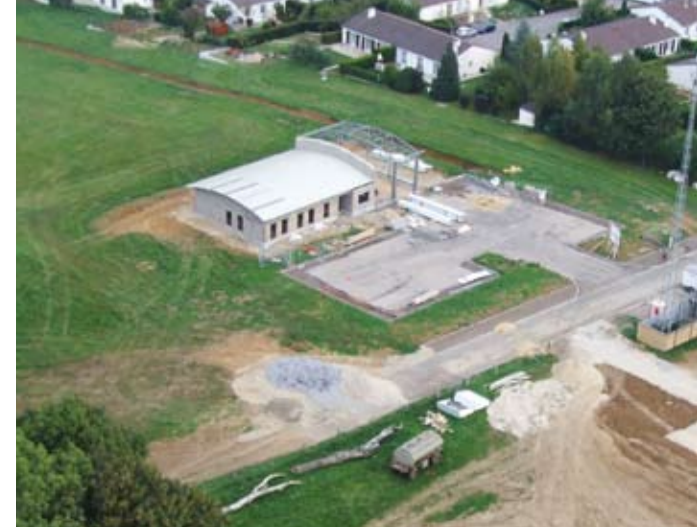
La caserne en cours de construction, en 2007.
