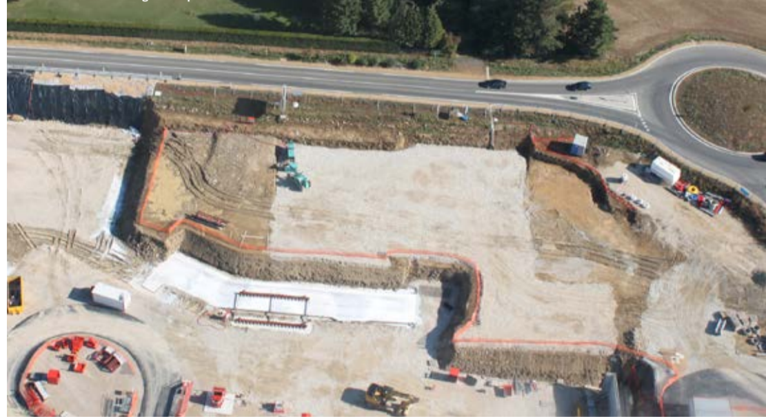
Les fondations du collège fin septembre 2012
