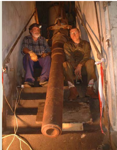
Remontage d'un tube de diamètre 100 mm pesant 1800 kg
